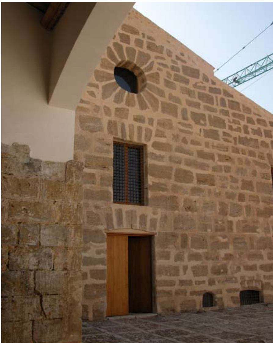
L'ingresso all'edificio della cantina. Sotto, una veduta interna della cantina e la facciata sud del corpo di fabbrica.
